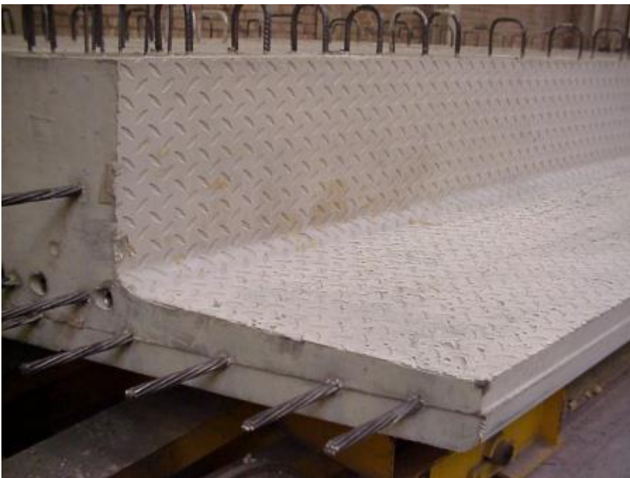
Bild 27: Details an der Oberfläche eines SVB-Fertigteils [Lit 2]
