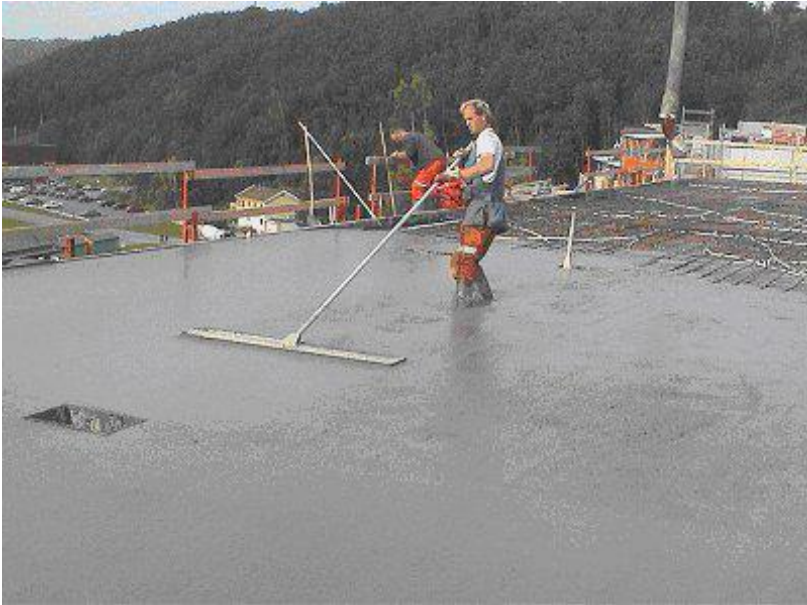
Bild 26: Nivellieren einer SVB-Oberfläche mit einem leichten Abziehbrett [Lit 2]
